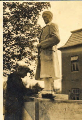
Socha „pluk. Švece“ a „Sokola“ před Sokolovnou byly zničeny ve II. svět. válce.
