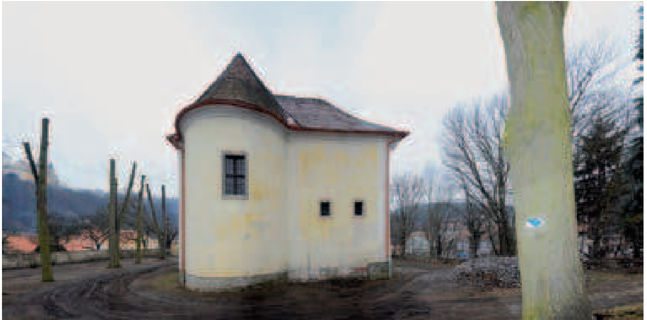
Pohled na stavbu od východu. / View of the building from the east. Foto Kamil Till
