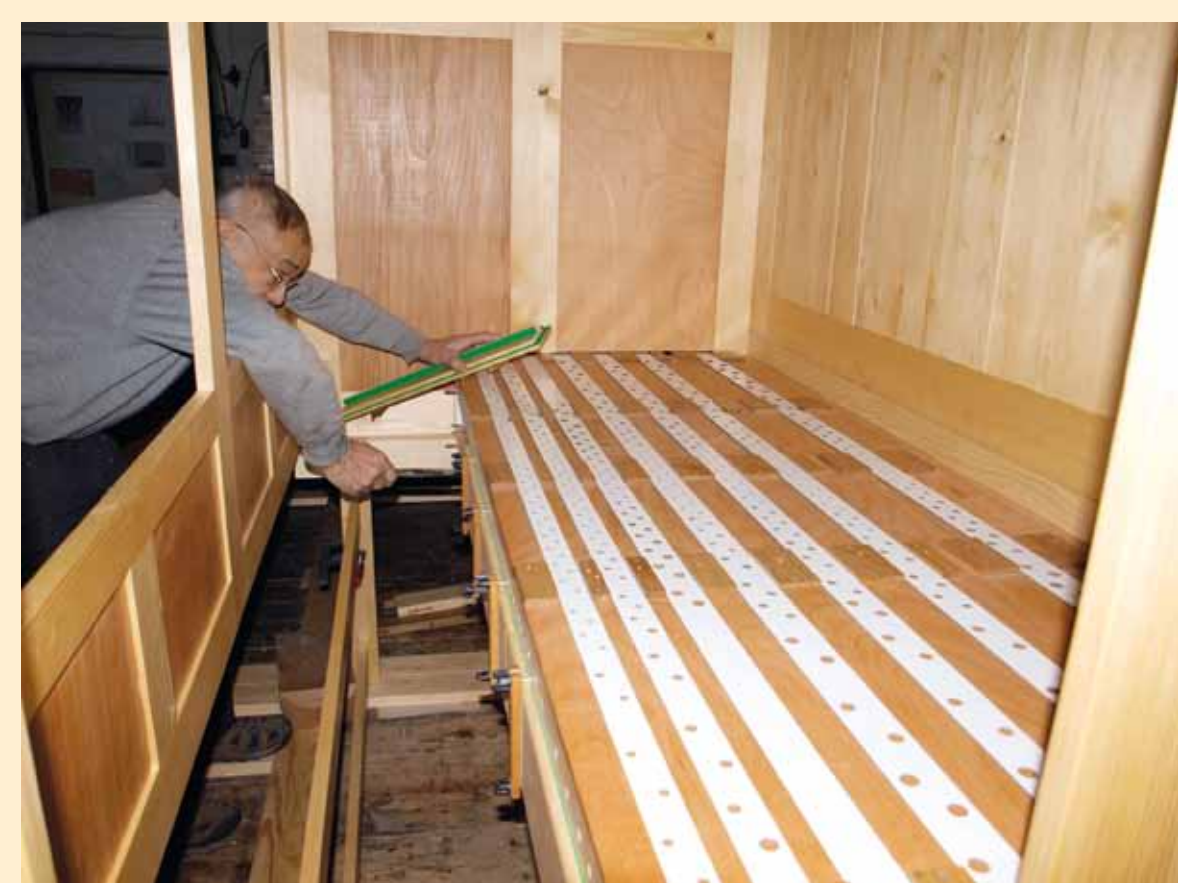
Montáž vzdušnice druhého manuálu v žaluziové skříni.
