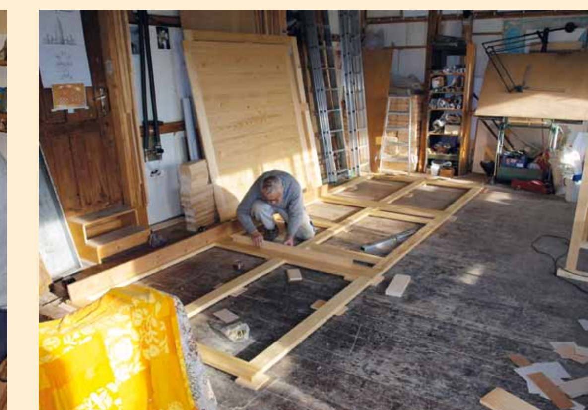
Vyvážení a usazení půdorysového rámu varhan.
