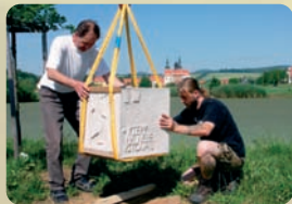
budování Poutní cesty
