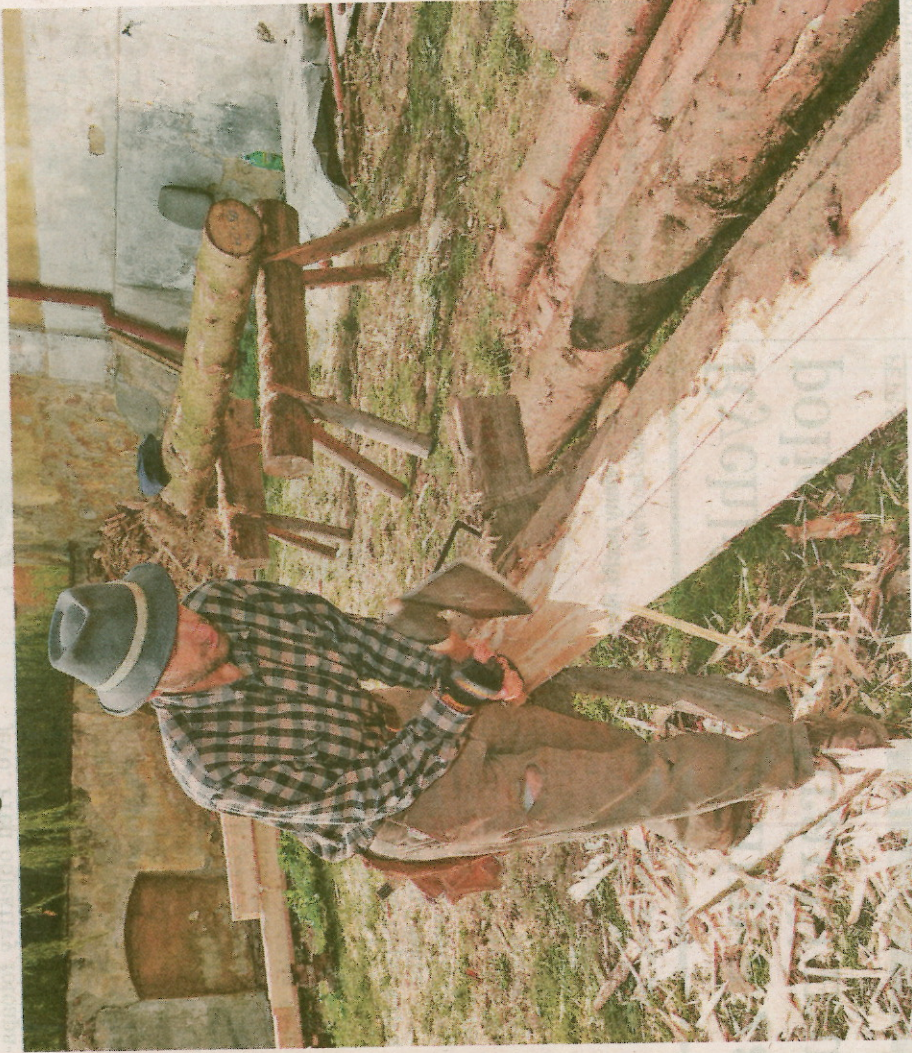
Tesaři z Tesařské huti v Karlových Varech přes léto opravovali část krovu na kostele sv. Petra a Pavla v Jeníkově. Jejich technika i nástroje jsou stejné jako u mistrů z minulých století. Foto: Deník/ M. Košťál
